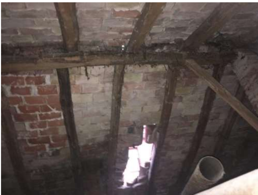
Imágenes de la cubierta desde el interior.
