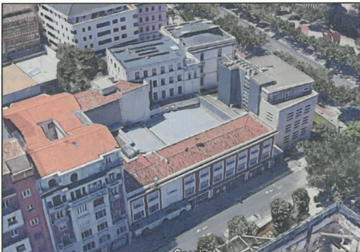
Aérea estado actual esquina Espolón – Duquesa de la Victoria
