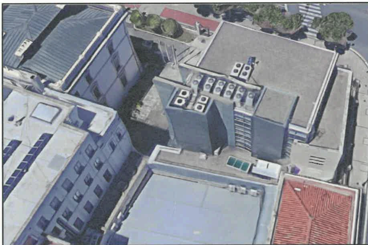
Aérea estado actual trasera Vara de Rey 1
