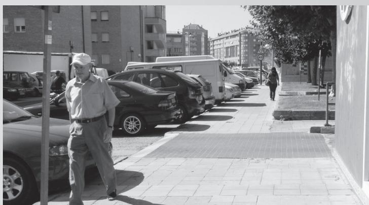
La remodelación ha tenido por objeto la renovación de la urbanización existente en la calle Eliseo Pinedo, mejorando las calidades de los pavimentos y servicios existentes y dando continuidad a las urbanizaciones peatonales. En concreto, se ha ampliado la anchura de las aceras, con sobreecho en los encuentros con las rotondas y los pasos de
