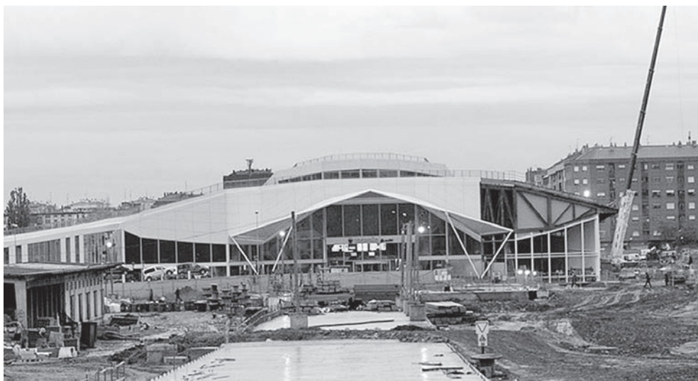
La futura estación de autobuses se ubicará en el terreno situado frente a la puerta de acceso de la nueva estación de tren
