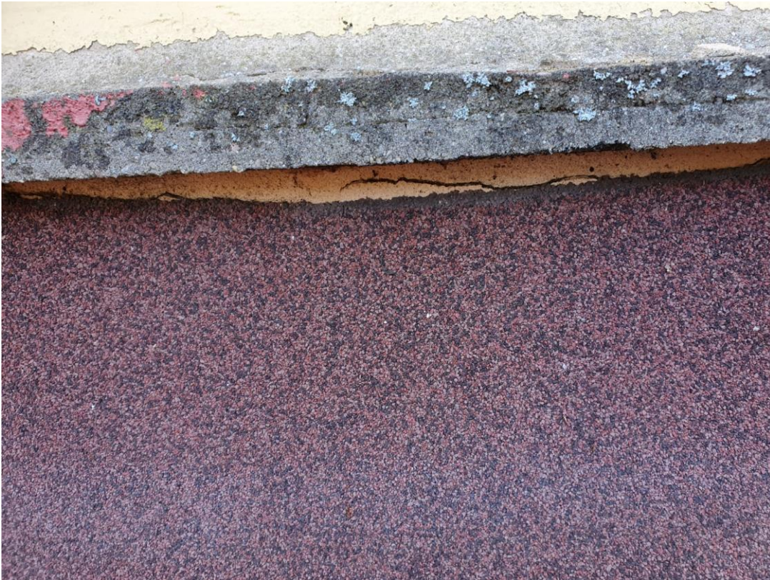
Foto 10 – Detalle de la impermeabilización en unión con alfeizar.
