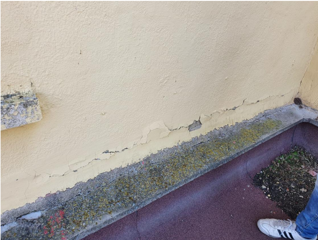
Foto 9 – Detalle de media caña de unión con el edificio anexo.
