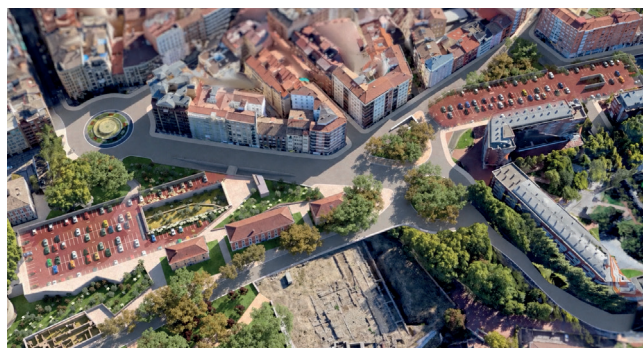
858 PLAZAS DE APARCAMIENTO EN DOS PARKINGS SUBTERRÁNEOS
