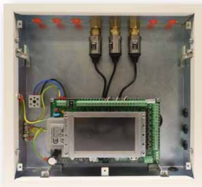
Interior Panel control y alarmas de zona fabricación CM
