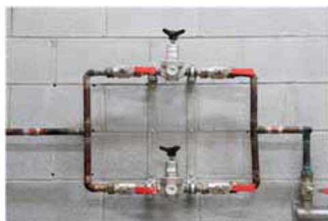
Grupo estabilizador fabricación Cahouet montaje kit CM
