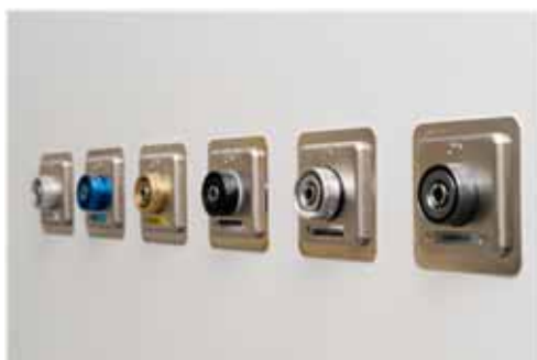
Tomas CM de gases medicinales y vacío fabricación CM
