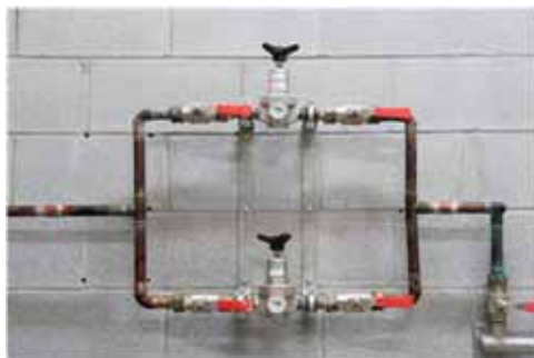
Grupo estabilizador fabricación Cahouet montaje kit CM
