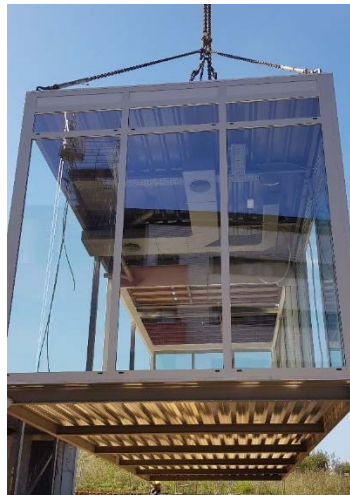
Ejemplo de módulo laminado en caliente
