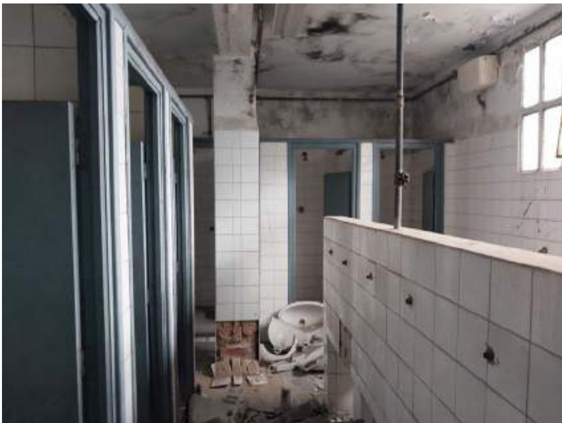
PARCELA A-3, AVENIDA DE LOBETE Nº 40 DE LOGROÑO (LA RIOJA) DETALLE DE LOS VESTUARIOS DE LA NAVE PERPENDICULAR A LA CALLE
