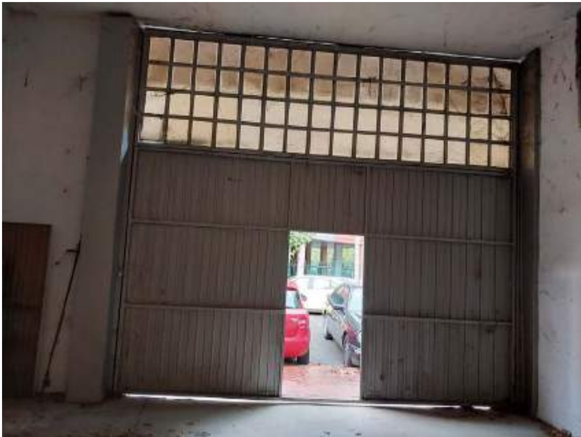
PARCELA A-11 CALLE NUEVA Nº 7 DE LOGROÑO (LA RIOJA) VISTAS DE LA PARTE ANTERIOR DE LA NAVE Y DE LA PUERTA
