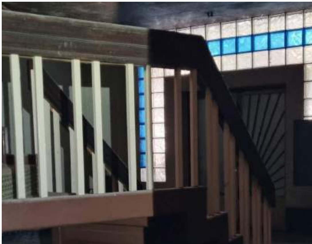
PARCELA A-10 CALLE NUEVA Nº 5 DE LOGROÑO (LA RIOJA) VISTAS DE LA ESCALERA DE ACCESO A LA ENTREPLANTA
