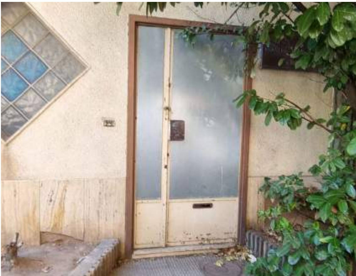
PARCELA A-10 CALLE NUEVA Nº 5 DE LOGROÑO (LA RIOJA) VISTA DE LA FACHADA Y DETALLE DE LA PUERTA
