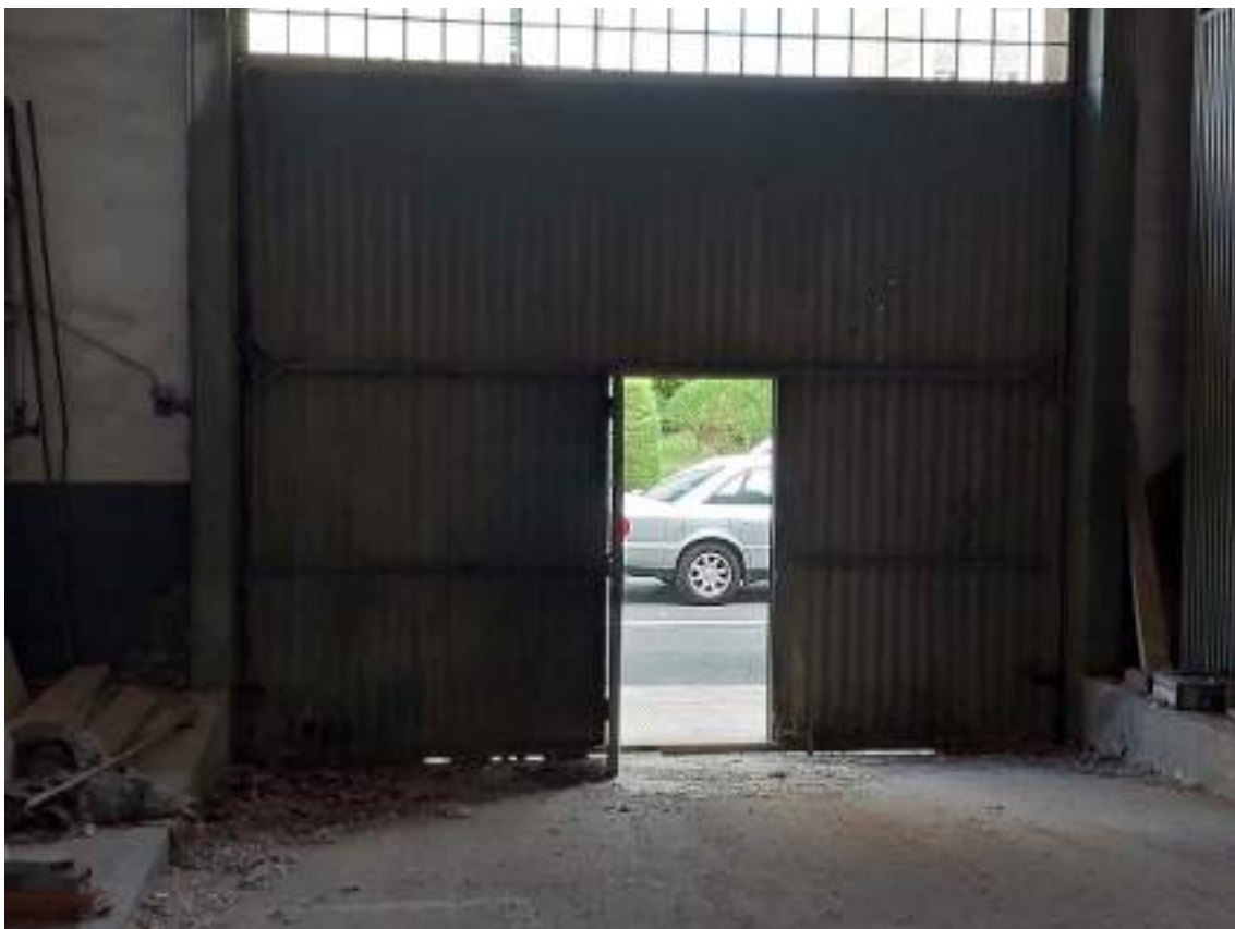
PARCELA A-3, AVENIDA DE LOBETE Nº 40 DE LOGROÑO (LA RIOJA) VISTAS DE LA FACHADA Y DETALLE DE LA PUERTA DE ACCESO DE VEHÍCULOS
