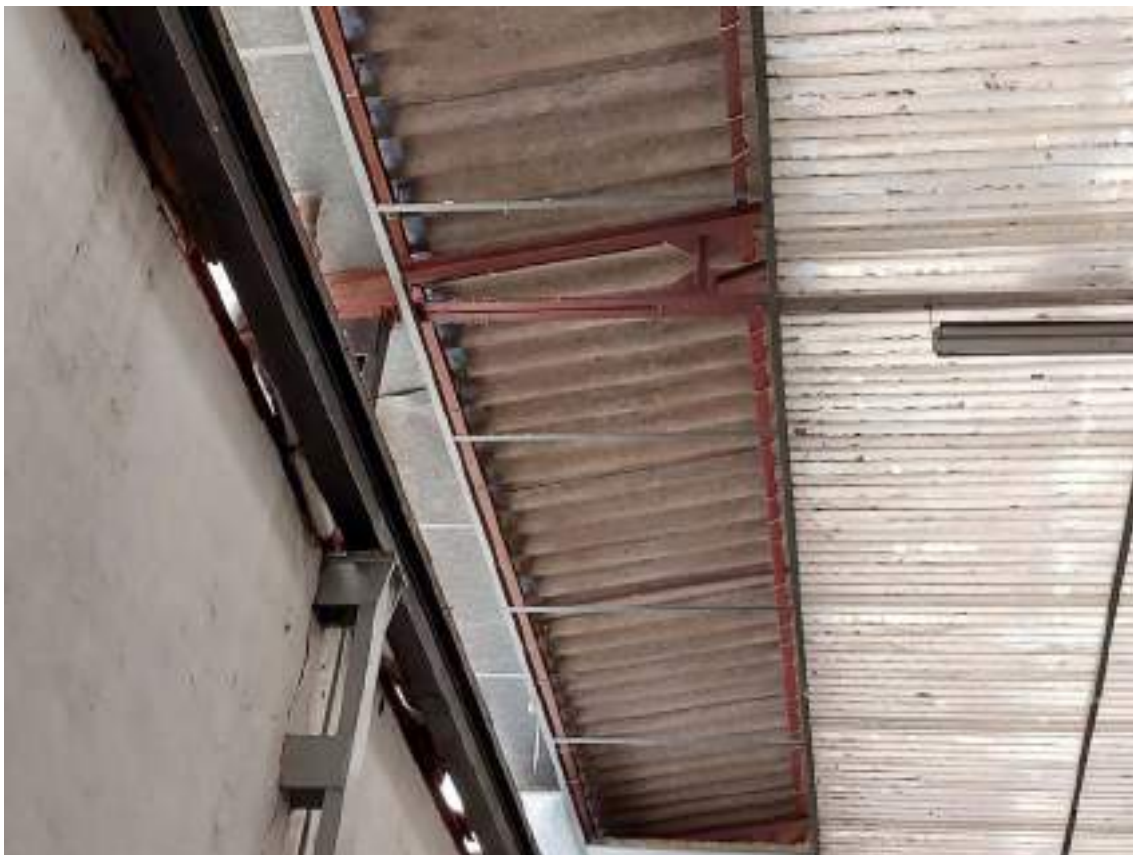
PARCELA A-11 CALLE NUEVA Nº 7 DE LOGROÑO (LA RIOJA) VISTA GENERAL DE LA NAVE Y DETALLE DE LA CUBIERTA
