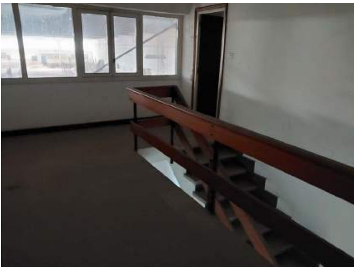
PARCELA A-3, AVENIDA DE LOBETE Nº 40 DE LOGROÑO (LA RIOJA) VISTAS DE LA ESCALERA DE ACCESO A LA PLANTA 1ª DE OFICINAS
