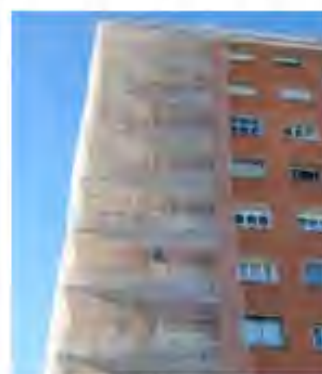
Figura 9. Instalación de una red de protección.
