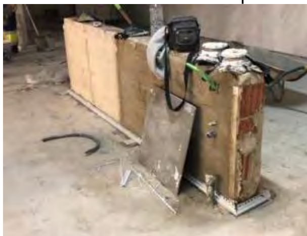
Murete separación termoarcilla
