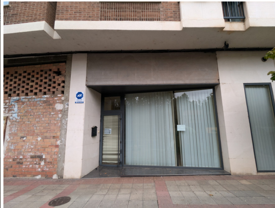
FACHADA C/DUQUES DE NÁJERA
