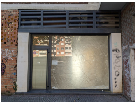
FACHADA CALLE REDONDILLA
