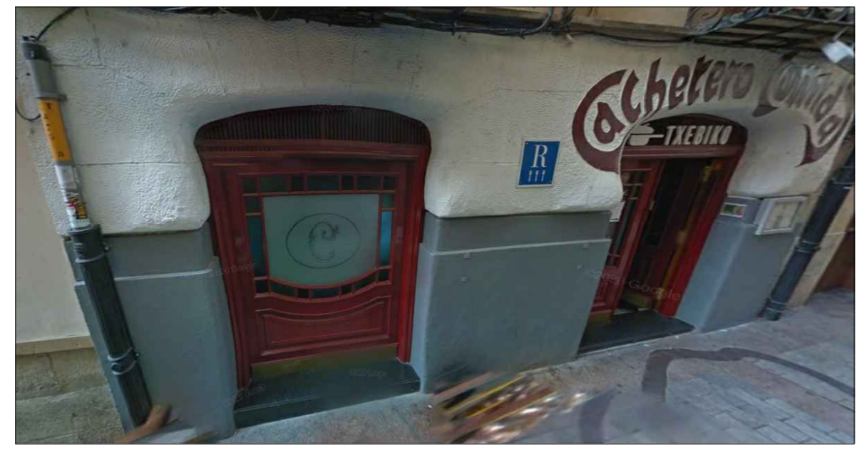
IMAGEN DE FACHADA ACTUAL
