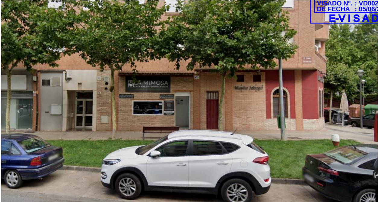
ESTADO ACTUAL DE FACHADA
