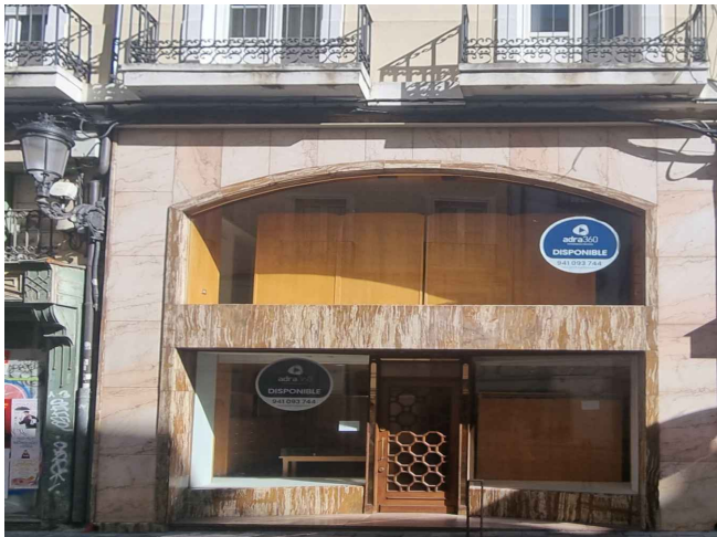
FACHADA EN ESTADO ACTUAL
